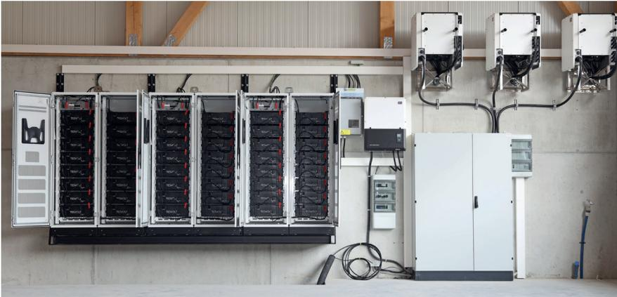
230 kWh Hochleistungs-Speicherkapazität auf nur 4 m<sup>2</sup> Fläche – die Batterietechnologie kommt von Tesvolt.
